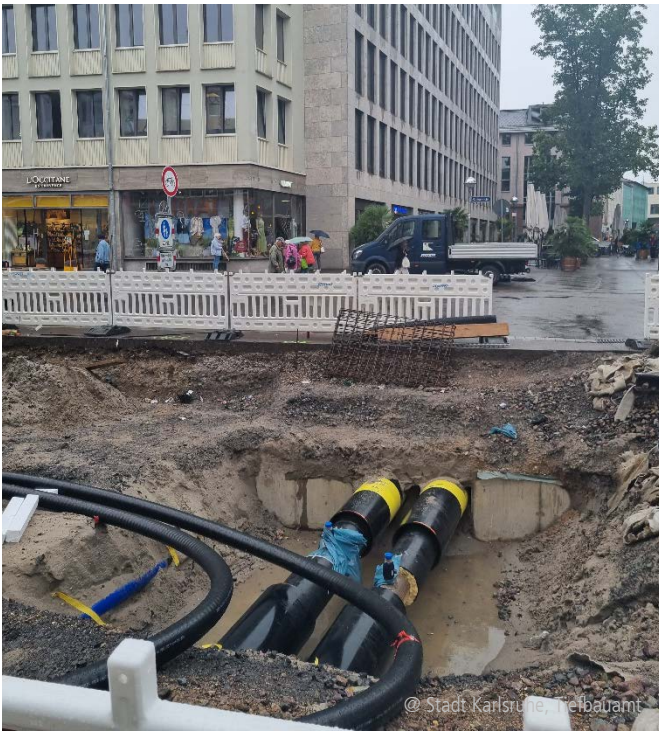
Abbildung 2: Querung Fernwärmeleitung im Baufeld 4
