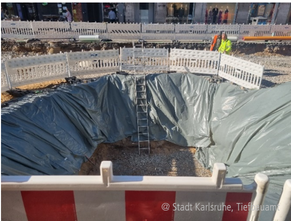
Abbildung 3: Baugrube für die neue Technikkammer/Technikkammer mit Schächten zur Be- und Endlüftung
